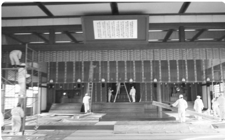
各所に脚立・長梯子・ビデを立てて作業を行なった
