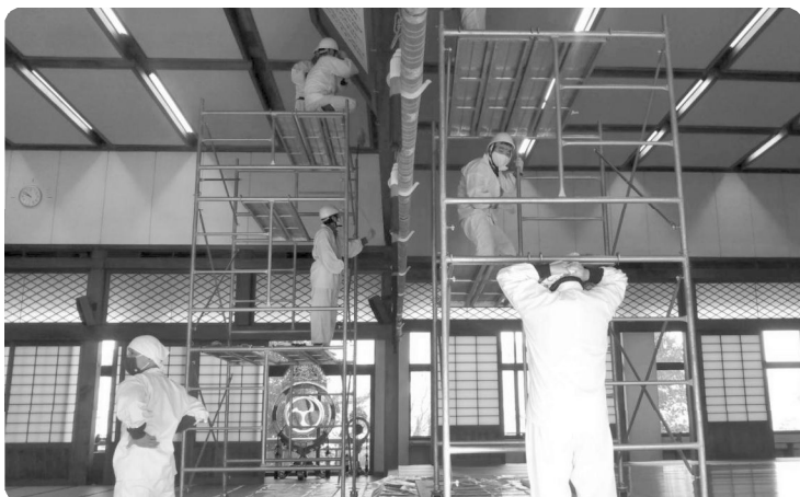
今回から高所作業者はヘルメットを着用
