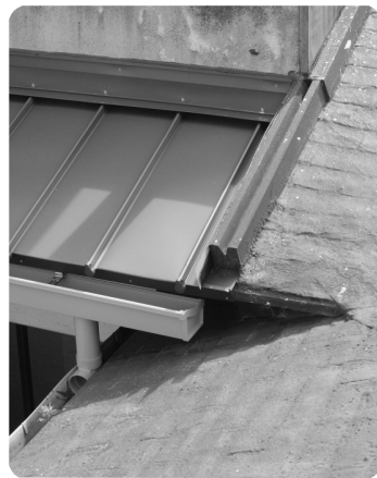
改修前後(渡り廊下接続部)
