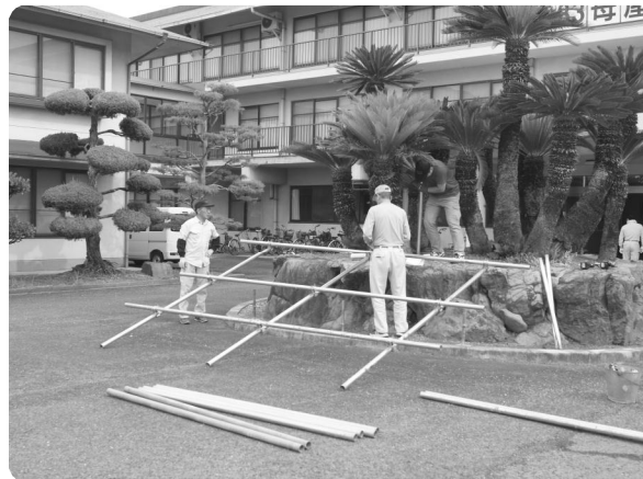
枠組みの準備
