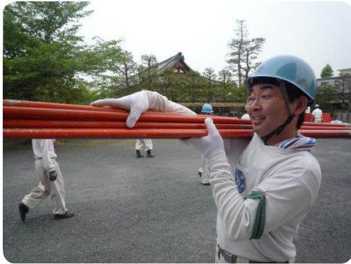
パレードスタンド周辺で作業
