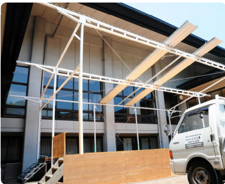
屋根の部分が取りはずされた(7/10)
