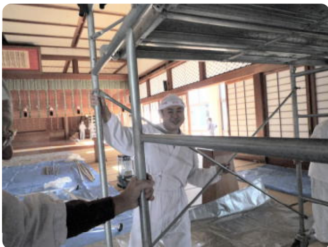
レールから外れないように 4人掛かりで移動する
