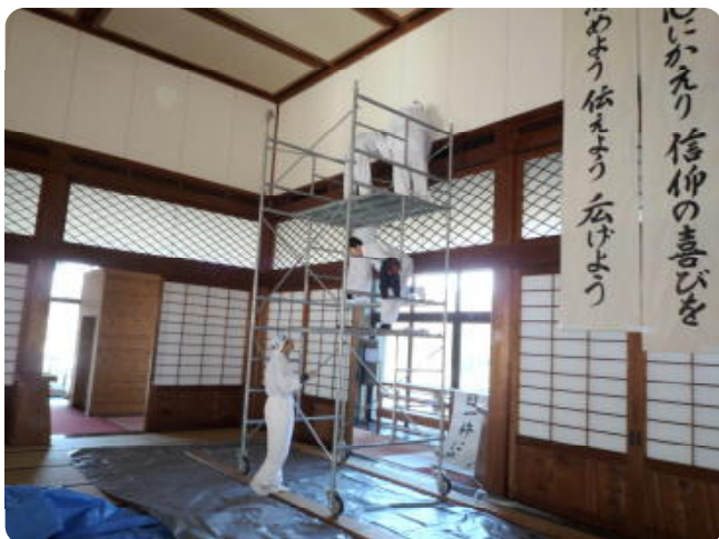
3階建てのビデでに上がり 棧の上も綺麗に掃除された
