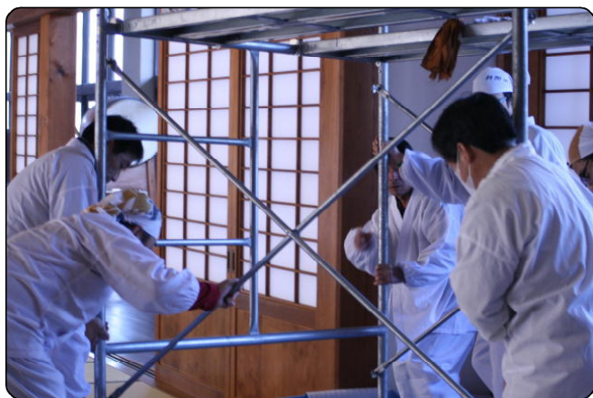
足場板レールの上に乗った 二階建ての台車を4人掛かりで動かす
