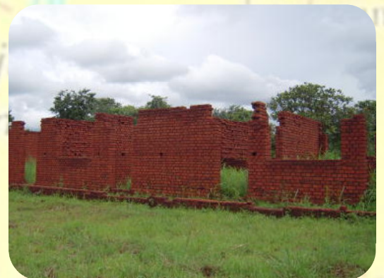
資金が足りなく、完成されない中学校校舎
